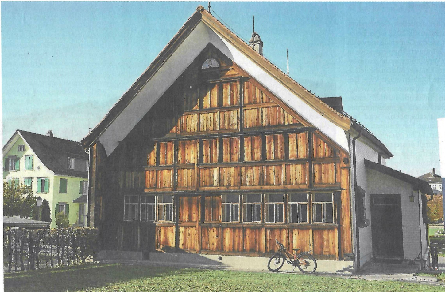
Dieses Appenzellerhaus an der Kaustrasse 5 in Appenzell soll für Parkplätze abgerissen werden.
