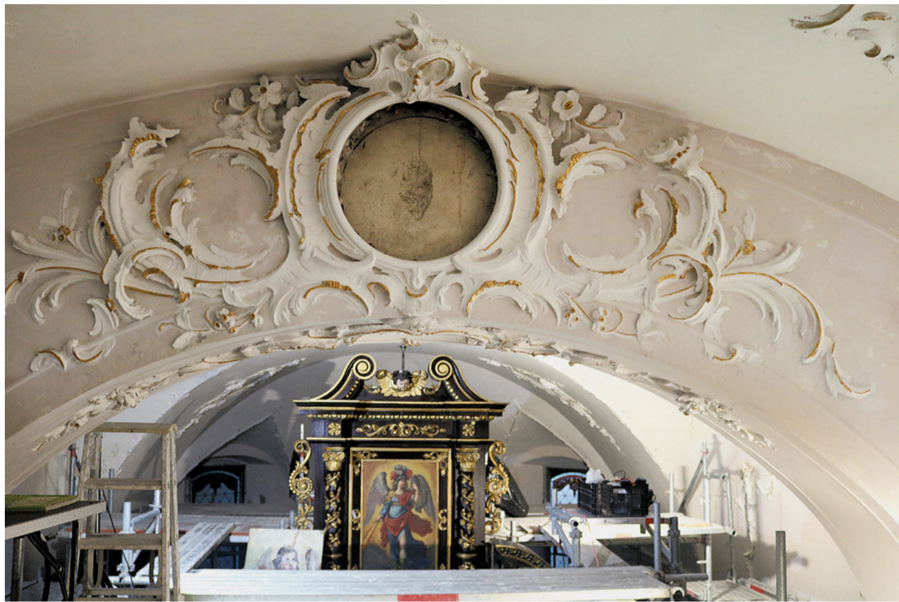
Das Kloster Wonnenstein wird derzeit renoviert.
